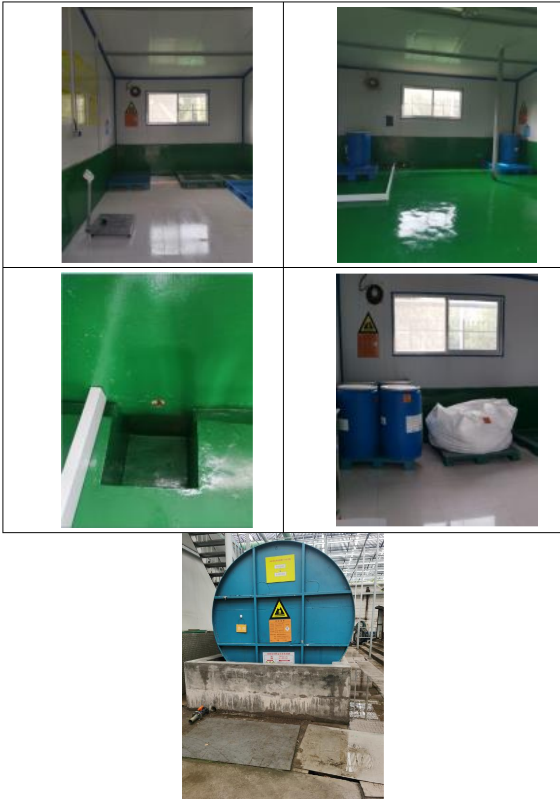
图 4.1-2 危险废物贮存间现状图
